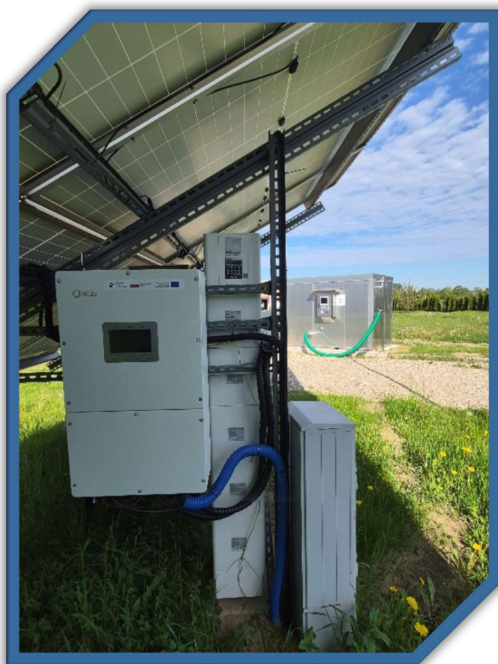
Magazyny Energii oraz Stację Zlewczą – OŚ Pisanica
