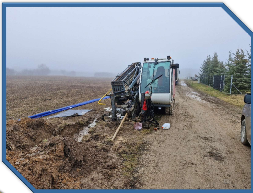
Budowa wodociągu DN 90 PE SDR 11 metodą przewiertu sterowanego - Romoty
