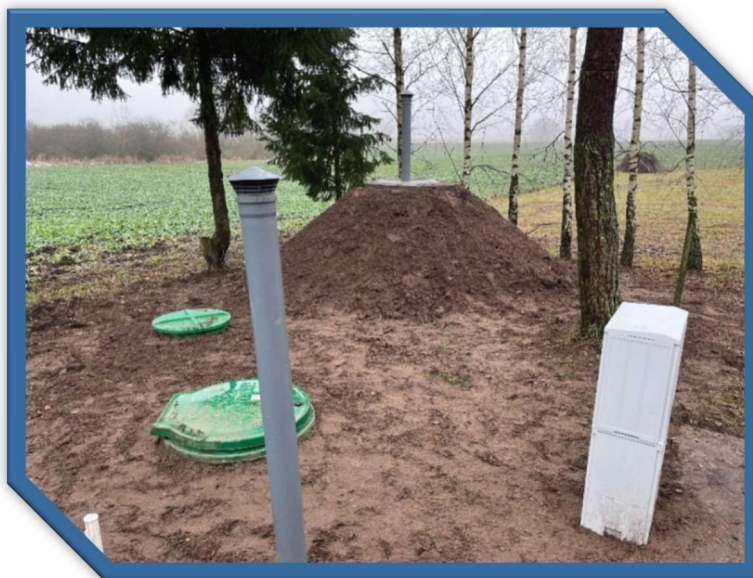
Przydomowa oczyszczalnia ścieków z kopcem rozsączającym
